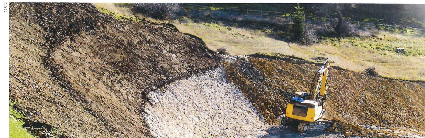
Placée sur le sous-sol (horizon C), une pelle mécanique redépose séparément la couche supérieure et la couche sous-jacente du sol en vue de leur valorisation.
